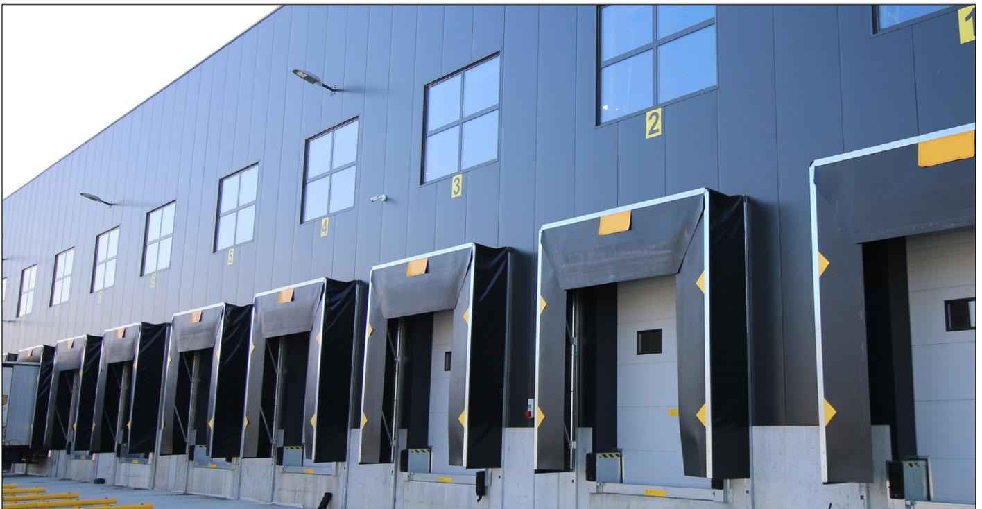
*Foto in alto: rivestimento fabbricato spedizioni/logistica e fornitura di baie di carico recessive con sigillanti. Applicazione pannello Star, giunto con fissaggio nascosto.*
