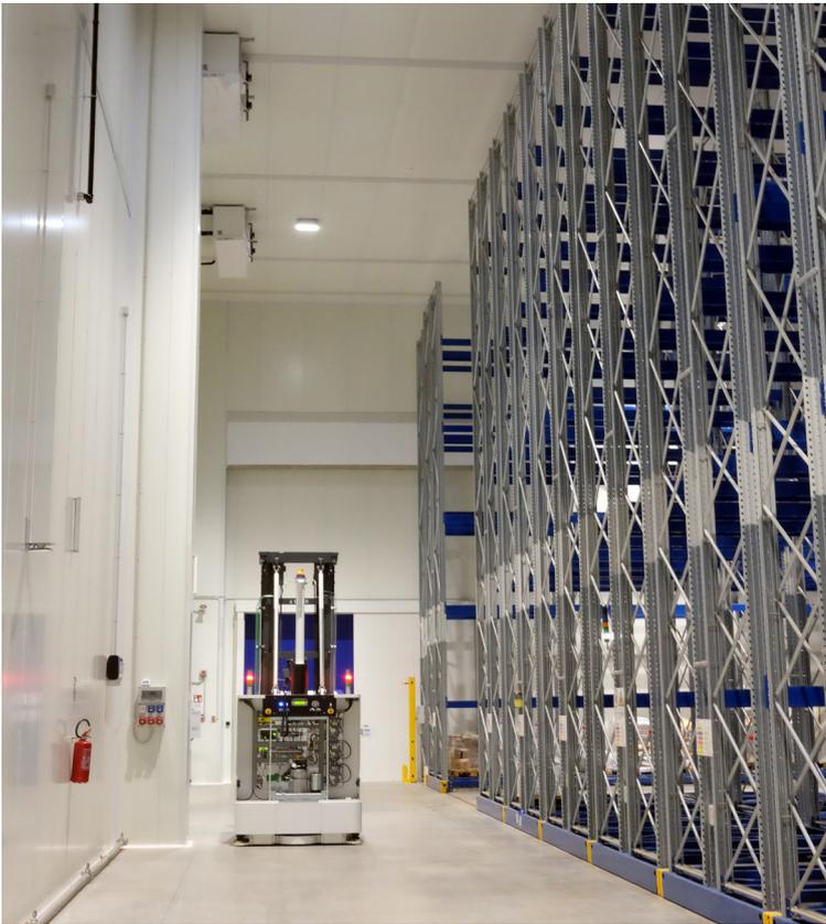
*Foto a sinistra: magazzino compattabile. In parete pannello **Fibernet certificato E.I.120** liscio **senza cuciture fino a 7,5 ext** con finitura bianco puro.*
