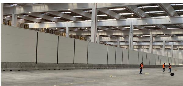
Foto in alto: setto divisorio in **pannello WSJ** orizzontale completo di carpenteria di sostegno vincolato a New Jersey
