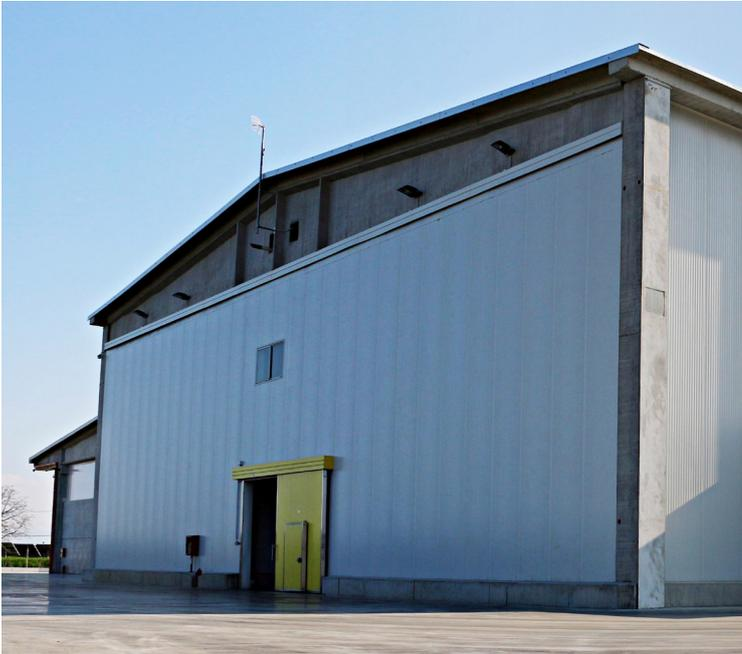
Foto in alto: cella frigo per conservazione frutta in regime di atmosfera controllata. Utilizzato **pannello WFJ spessore 200 mm** per combinare l'esigenza di tenuta stagna del giunto schiumato con la portanza richiesta dall'altezza del fabbricato.
