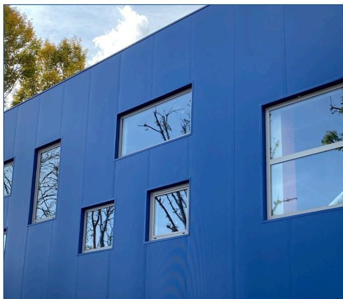
Il pannello sandwich coibentato Star a fissaggio nascosto trova largo impiego nel rivestimento di moduli prefabbricati, garantendo un ottimo rapporto costo - prestazione e combinando estetica, leggerezza, resistenza, isolamento termico, facilità di installazione e rispetto delle normative antincendio.
