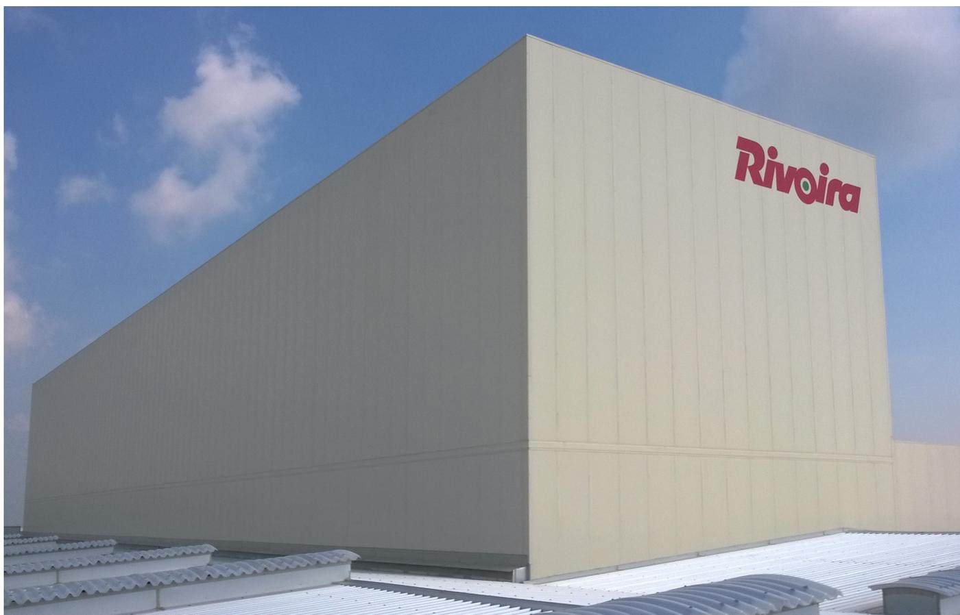
Foto in alto: magazzino automatizzato. Fornitura e progettazione di **pannelli parete e copertura tipo WFJ** a giunto schiumato con finitura esterna in Tata Steel garanzia 30 anni.
