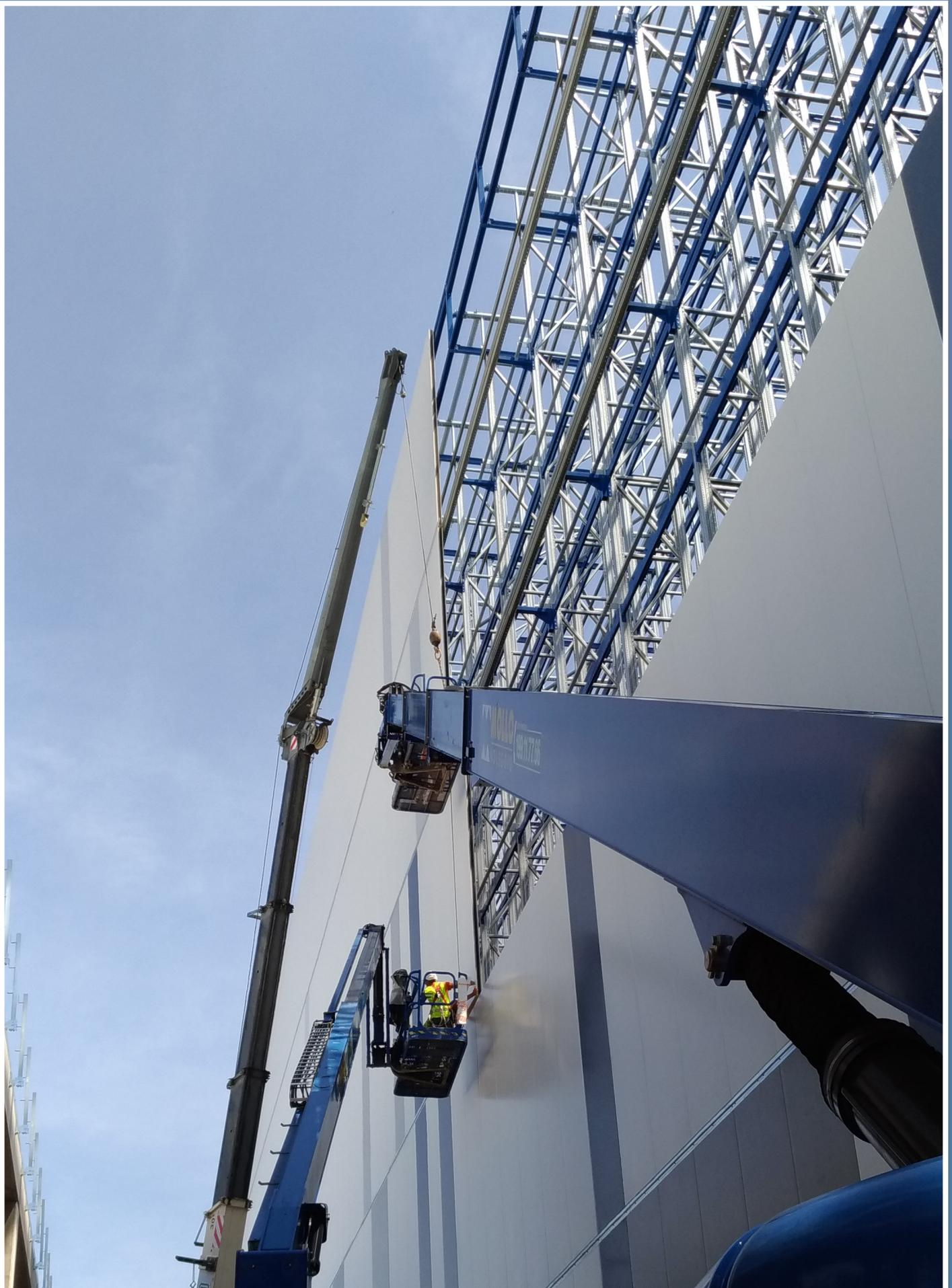
Foto in alto: magazzino automatizzato rivestito con **pannello Alfa2 super** (passolargo) finitura liscia in 8 colorazioni differenti.
