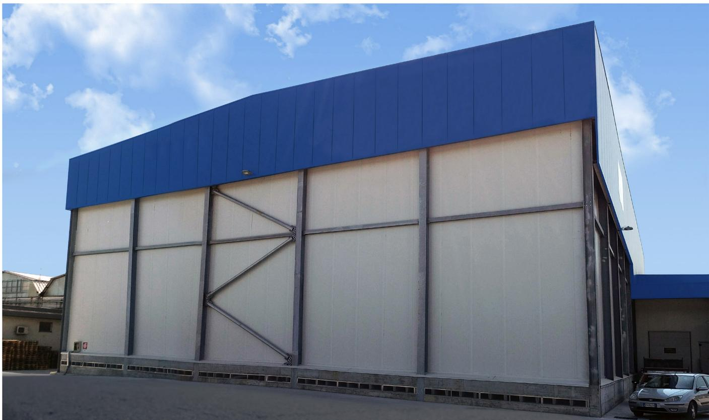
*Foto in alto: cella bassa temperatura con **pannello WFJ 240 mm**, coibentazione pavimento, veletta in Ral blu personalizzato realizzata in **Star 50 mm**, copertura in **Delta 5**.*
